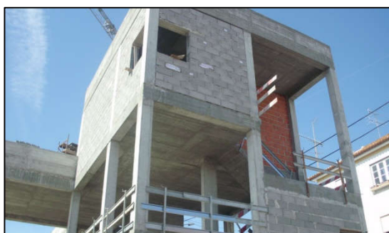
Fig. 9: Obras de construção do novo CAO.
